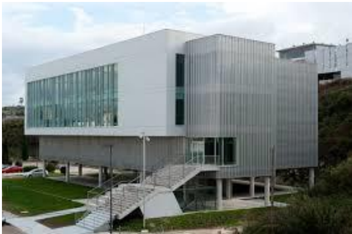
Edificio Área Científica
